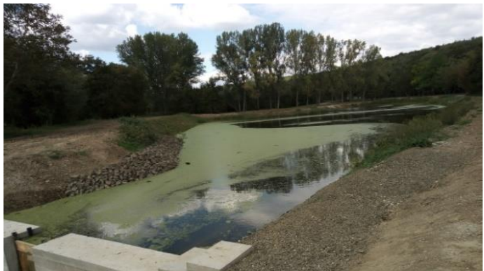
Obr. 21. - Realizačné práce v obci Püspökszilágy. (Foto: samospráva obce Püspökszilágy)
