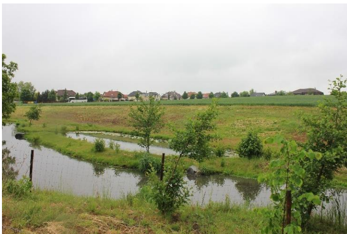
Obr. 2. - V českej obci Hostovice opravou zákrut úseku brehu v obci a sploštením záplavového územia dosiahli pokles povodňového rizika a na mieste bývalého kanála vytvorili príťažlivý park. (Foto: Farkas Viktor Mátyás, WWF HU)
