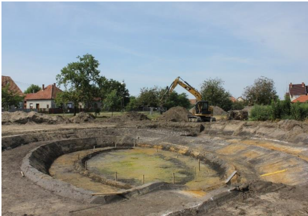
Obr. 37. – Vytvorenie rozmanitej, nerovnomernej geometrie dna v obci Ruzsa. Ploché spády sa striedajú s viacúrovňovými obrubnicami, ich vytvorenie si od zhotoviteľa vyžadovalo viac pozornosti a práce, a v porovnaní s použitím najprudšieho spádu ešte aj znižujú objem nádrže. Ale plochý breh je zároveň bezpečný a poskytuje pestrý biotop pre vznik vodnej flóry a fauny. (Foto: Farkas V. Mátyás, HU)
