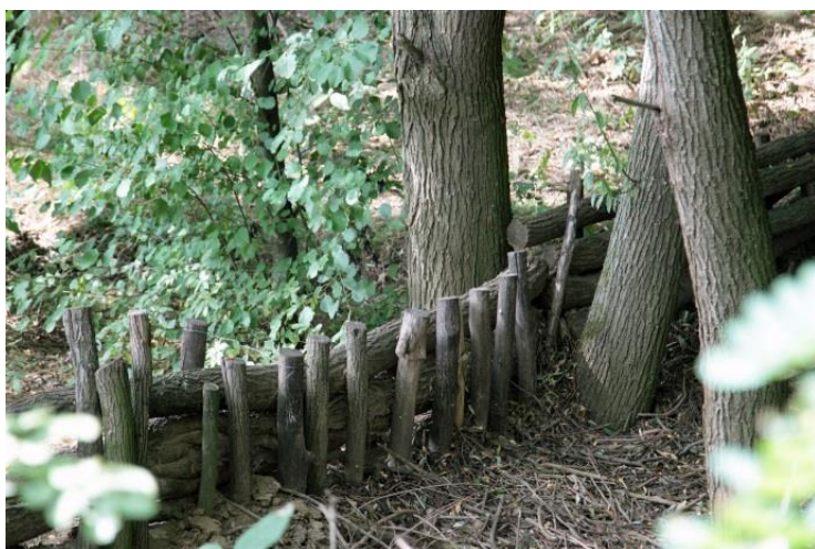
Obr. 22. - Kmeňové hrádze v Püspökszilágy v suchom období a pri „práci“. (Foto: Ministerstvo vnútra, samospráva obce Püspökszilágy)
