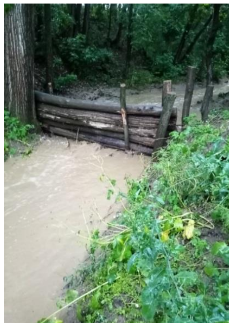
Obr. 22. - Kmeňové hrádze v Püspökszilágy v suchom období a pri „práci“. (Foto: Ministerstvo vnútra, samospráva obce Püspökszilágy)
