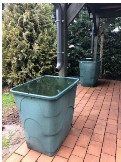
Obr. 12. - Jednoduchý a lacný systém na zadržanie a využitie zrážkovej vody na pozemku. (Foto: Szabó Zsófia, Bática)
