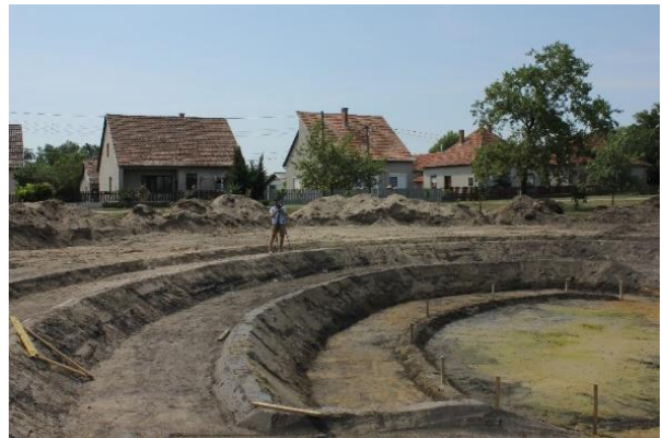
Obr. 26. - Vytváranie rozmanitého koryta jazera na vnútornom území obce Ruzsa. (Foto: WWF HU)
