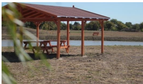
Obr. 40- Hotové lavice s prístreškom
